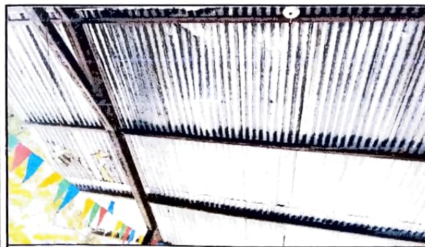
Foto 5: TECHADO DEL SALON. SUSTITUCIÓN DE LÁMINA, POR LÁMINA TROQUELADA ALUZINC CALIBRE 26
