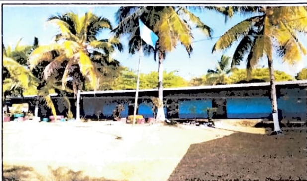
Foto 2: PRIMER MÓDULO DEL ESTABLECIMIENTO Y ÁREA VERDE, REPARACIÓN DE SISTEMA ELECTRICO
