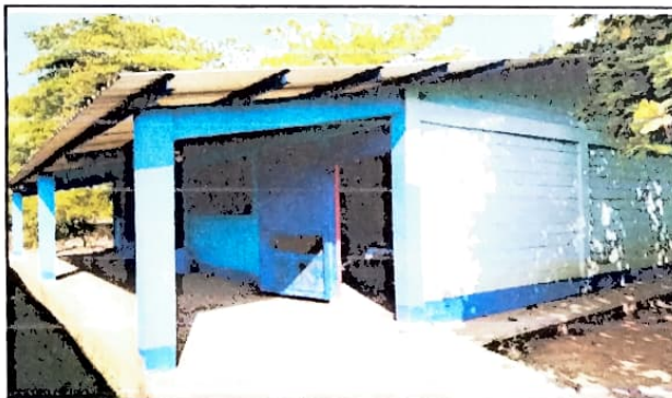
Foto 3: MODULO 2, REPARACIÓN DE SISTEMA ELECTRICO
