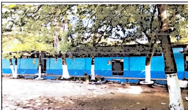
Foto 4: TERCER MÓDULO DEL ESTABLECIMIENTO, REPARACIÓN DE SISTEMA ELECTRICO
